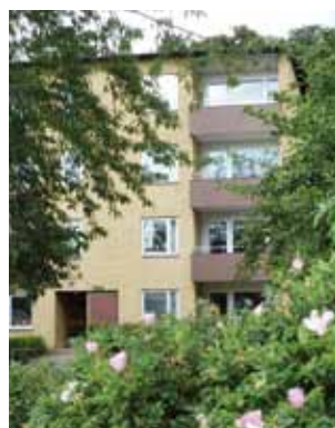
Brogårdens fasader före renovering
