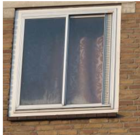
Fig. 8 Windows at Van der Lelijstraat
